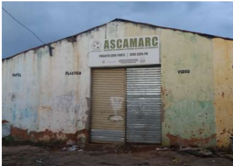
Figura 94 - Sede da ASCAMARC – Associação dos Catadores de Materiais Recicláveis de Cajazeiras
