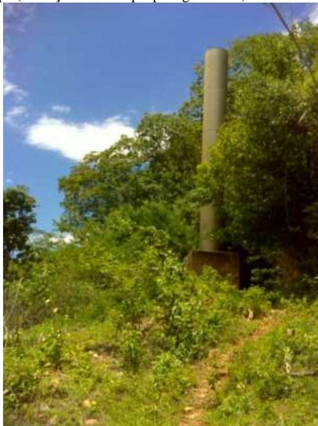
Figura 42 - Stand Pipe (transição do recalque para gravidade)
