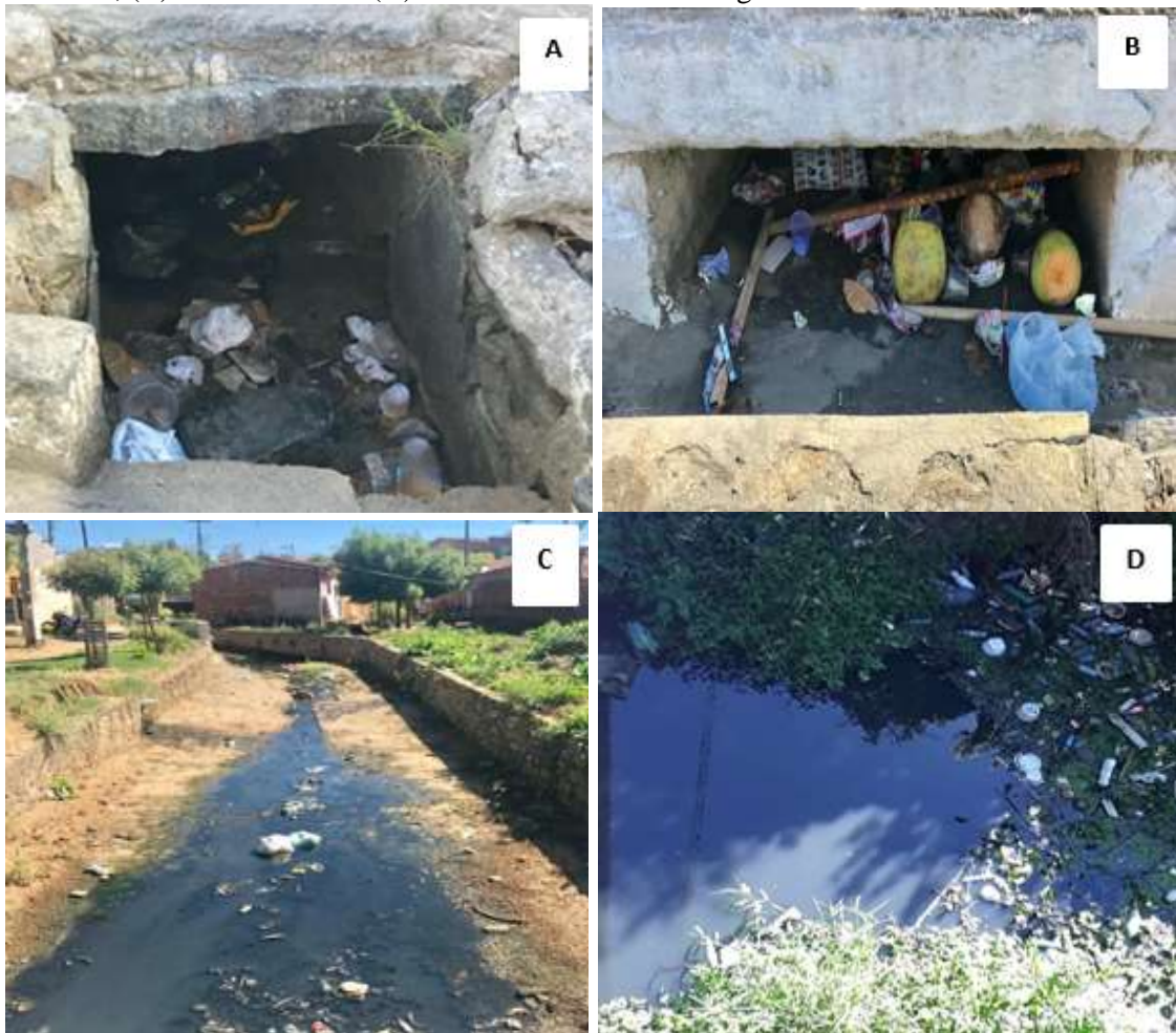
Figura 78 - Acúmulo de resíduos sólidos: (A) Rua Joaquim Costa, (B) Rua Coronel Juvêncio Carneiro, (C) Rua São José e (D) Avenida José Donato Braga
