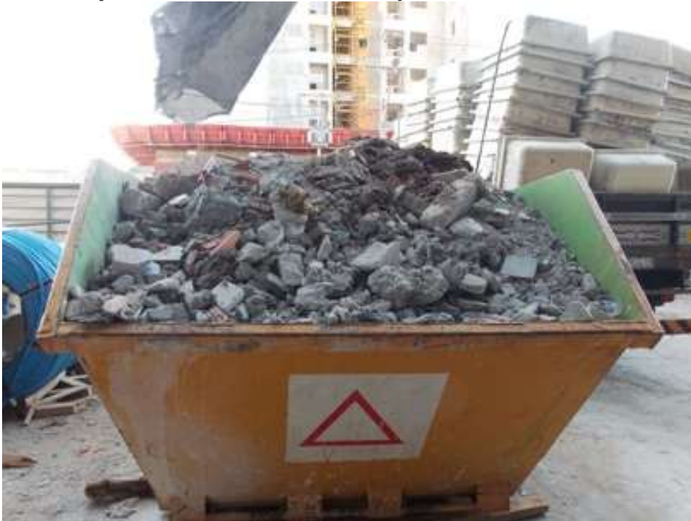
Figura 85 - Serviço de coleta dos resíduos da construção civil
