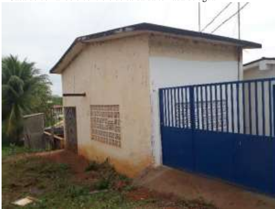
Figura 52 - Casa de comando e controle de saída da tomada de água
