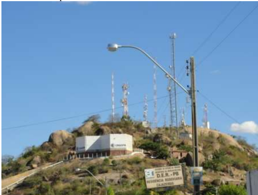
Figura 45 - Reservatório apoiado de 2.000m 3
