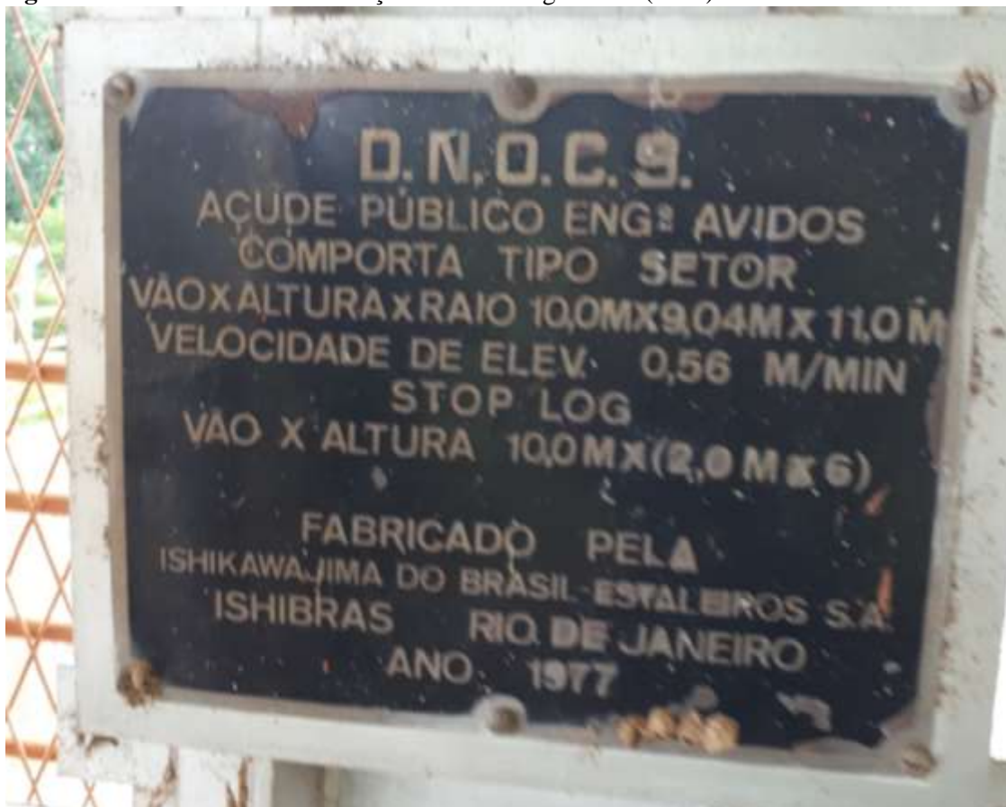
Figura 21 - Placa alusiva a construção de novo sangradouro (1977)
