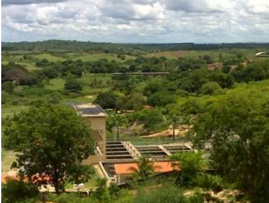
Figura 29 - Estação de tratamento
