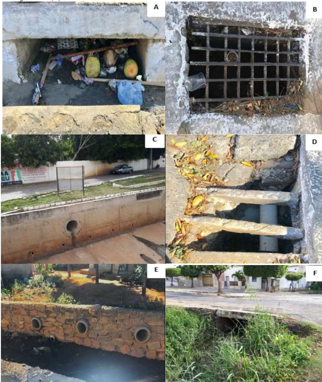
Figura 70 - Bocas de lobo: (A) Rua Coronel Juvêncio Carneiro, (B) Rua Joaquim Costa, Lançamento de Galeria em Canal (C) Rua Padre Rolim, (D) e Rua Arsênio Rolim Araruna, (E) Rua Projetada e (F) Avenida Francisco Matias Rolim
