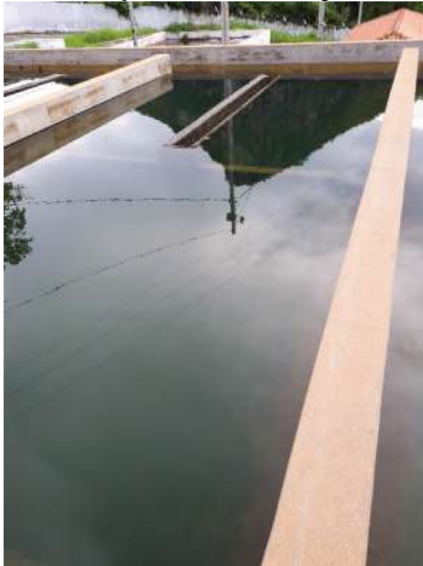
Figura 33 - Decantador de uma Estação de Tratamento de Água
