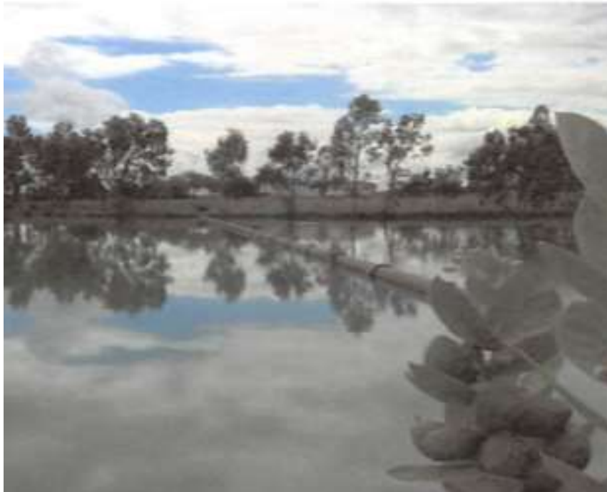
Figura 66 - Lagoa de Estabilização
