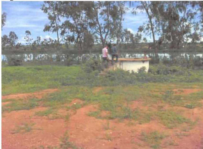
Figura 67 - Lagoa e Caixa de Entrada
