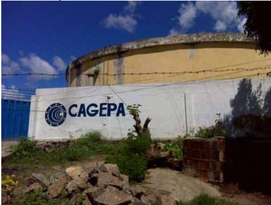
Figura 43 - Reservatório apoiado de 1.000m 3
