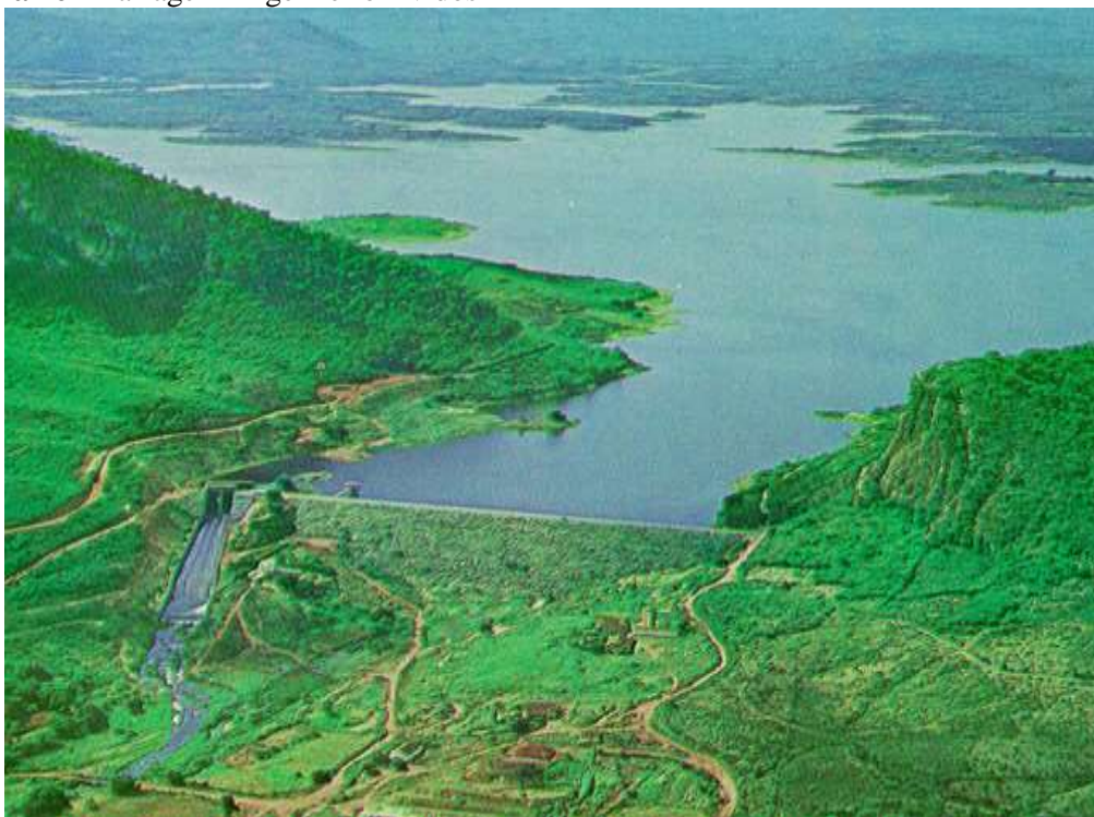
Figura 16 - Barragem Engenheiro Ávidos
