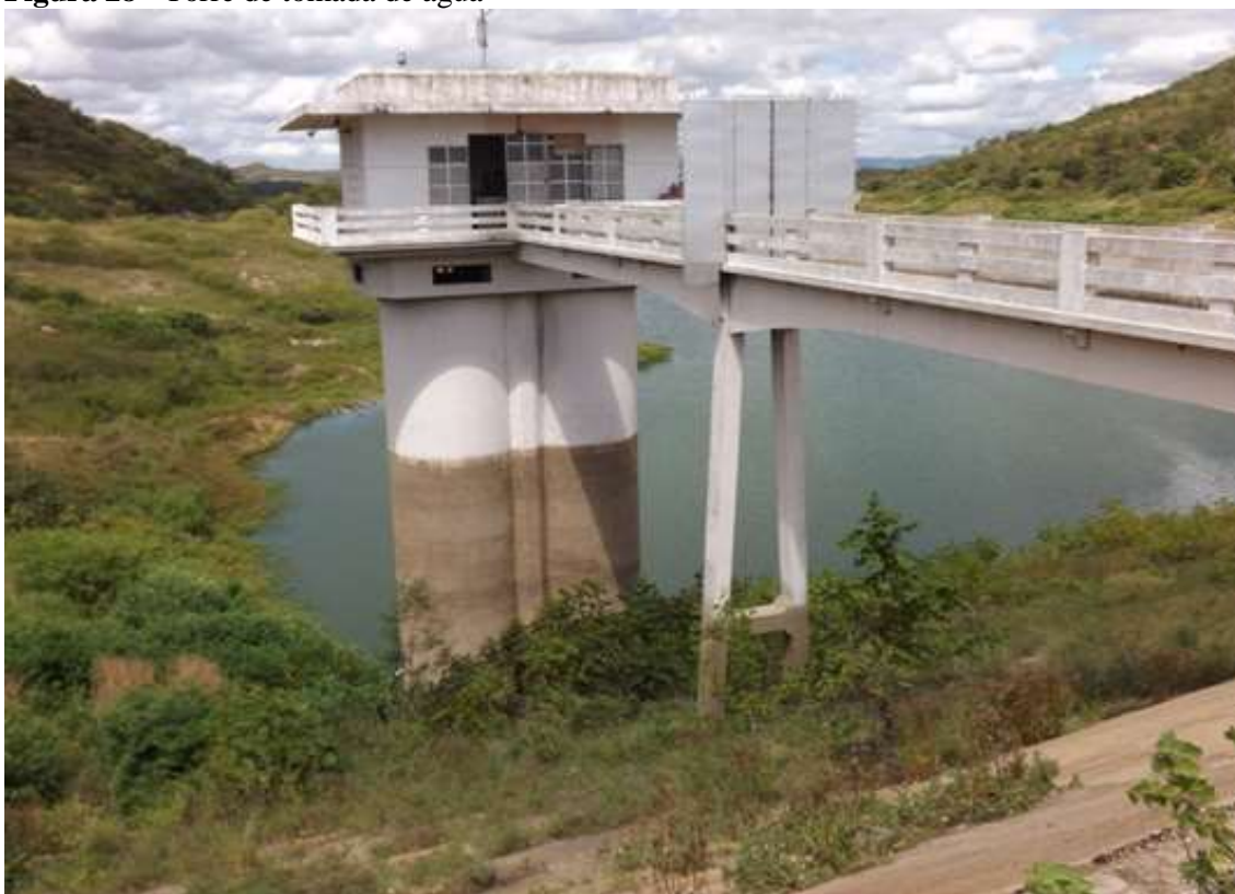
Figura 28 - Torre de tomada de água
