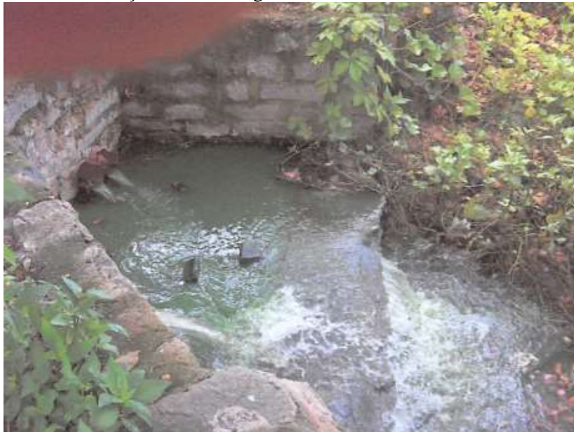
Figura 68 - Estrutura de lançamento dos esgotos
