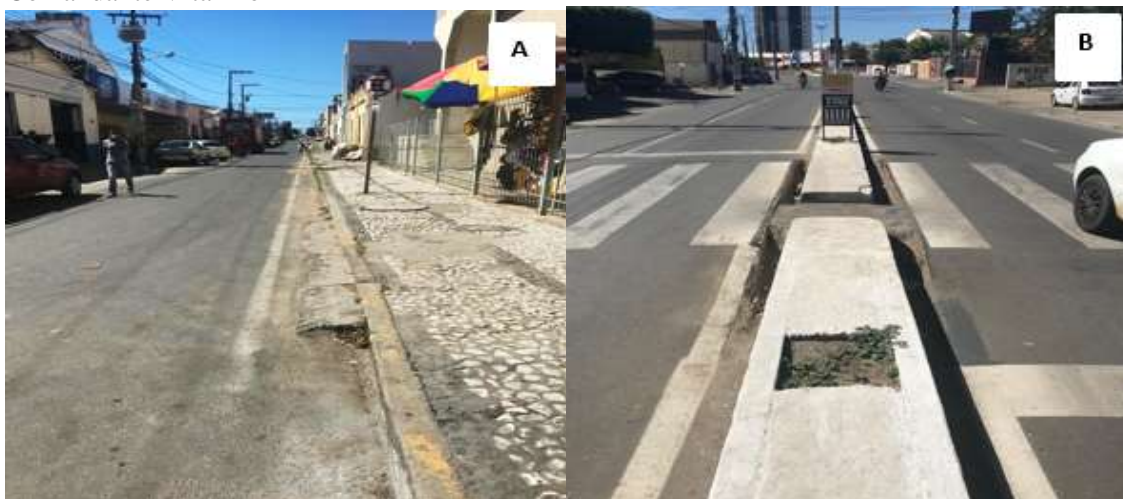
Figura 74 - Identificação de vias asfálticas: (A) Rua Doutor Bonifácio Moura e (B) Avenida Comandante Vital Rolim
