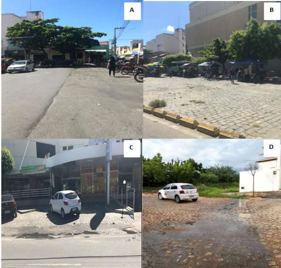
Figura 76 - Identificação de áreas sujeitas a alagamentos: (A) Rua Coronel Guimarães Manoel Mariano, (B) Rua Sebastião Bandeira de Melo, (C) Avenida Comandante Vital Rolim e (D) Rua Francisco Assis de Sousa Chagas (Loteamento Alto da Colina)
