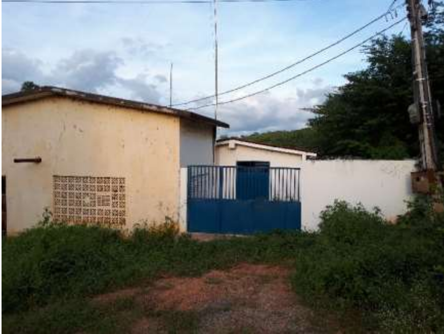
Figura 54 - Estação Elevatória de Água Bruta
