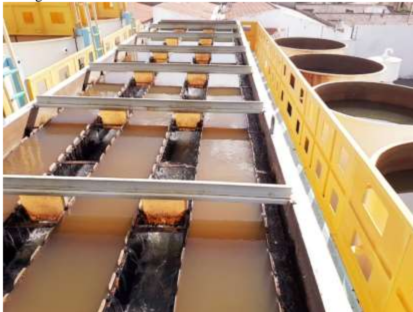
Figura 58 - Vista geral da ETA
