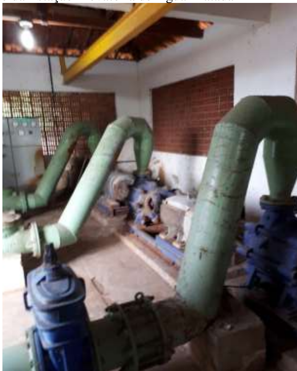
Figura 38 - Edificação da Estação Elevatória de Água Tratada
